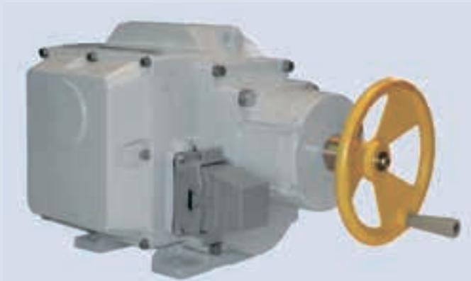
Механизмы предназначены для перемещения регулирующих (запорных) органов арматуры в АСУ ТП в соответствии с командными сигналами регулирующих и управляющих устройств, а также для автоматического или дистанционного управления неполноповоротной трубопроводной запорно-регулирующей арматуры в атомной, тепловой энергетике, машиностроении и т.д.
