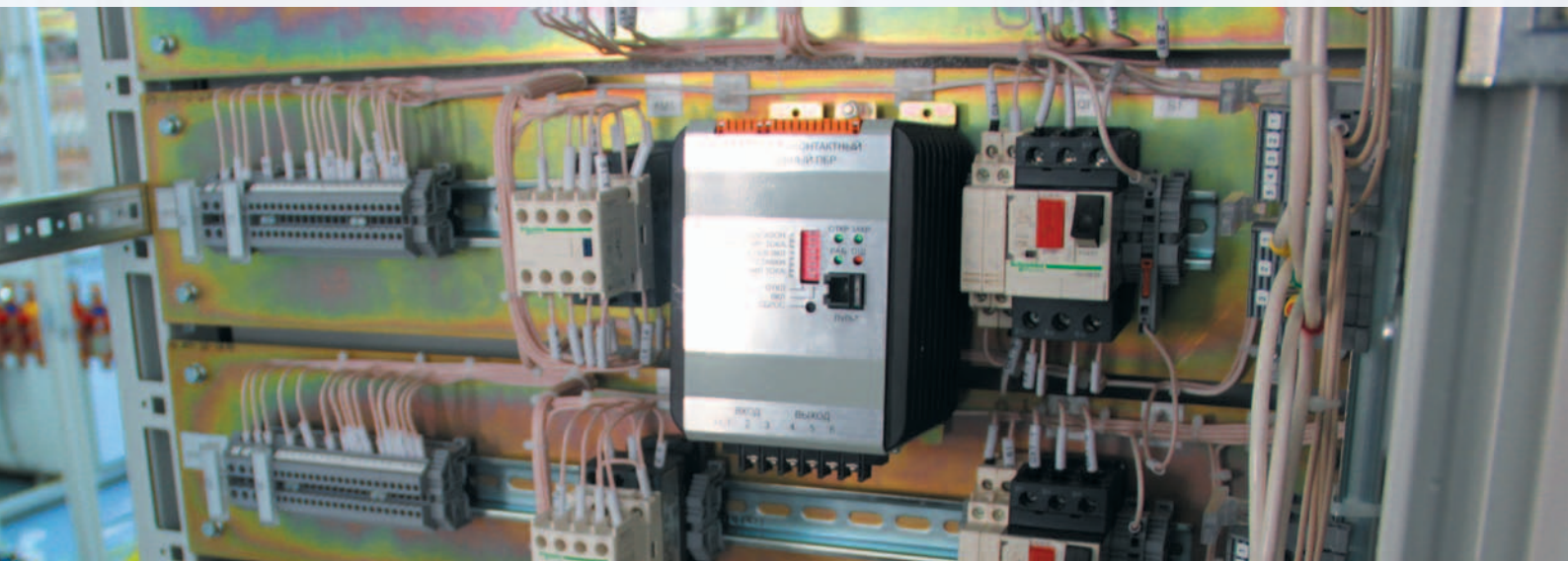
Пускатель бесконтактный реверсивный интеллектуальный ПБР-И в составе шкафа управления
